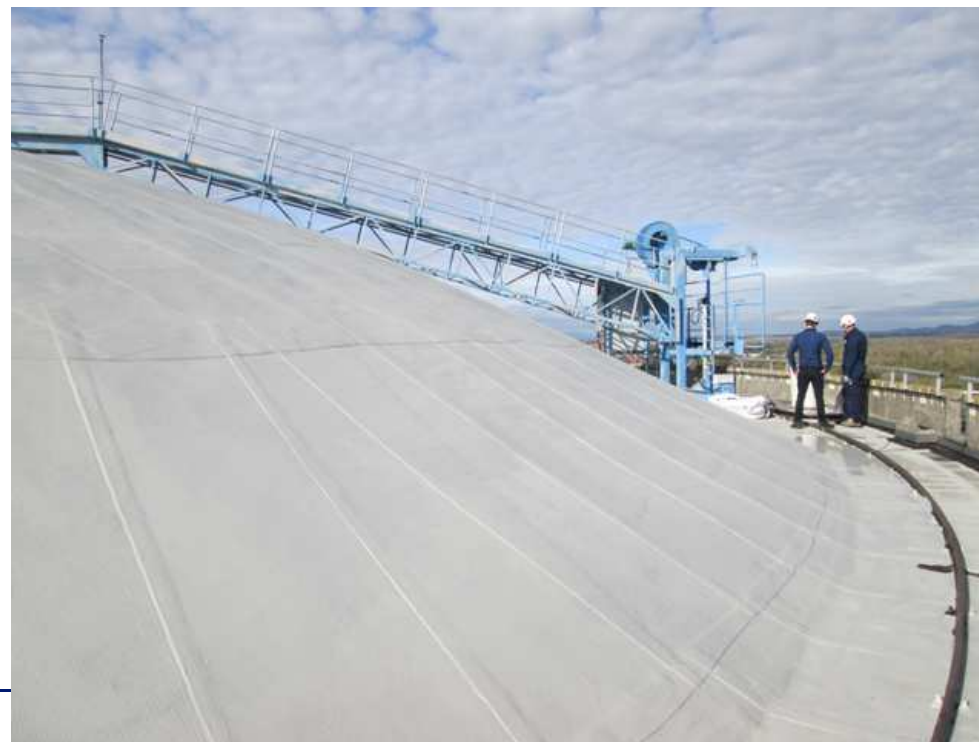
La hauteur du Bâtiment Réacteur est de 50m
