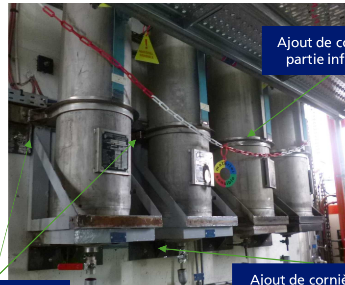
APRES remise en conformité
