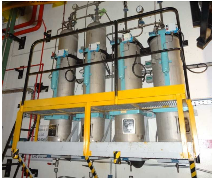
AVANT remise en conformité
