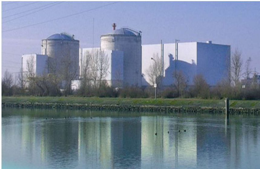
Centrale de Fessenheim (Haut-Rhin)
