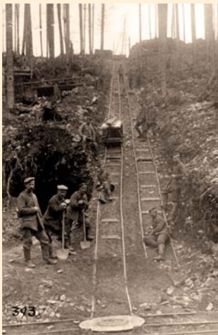
Câble transbordeur allemand du Barrenkopf.
